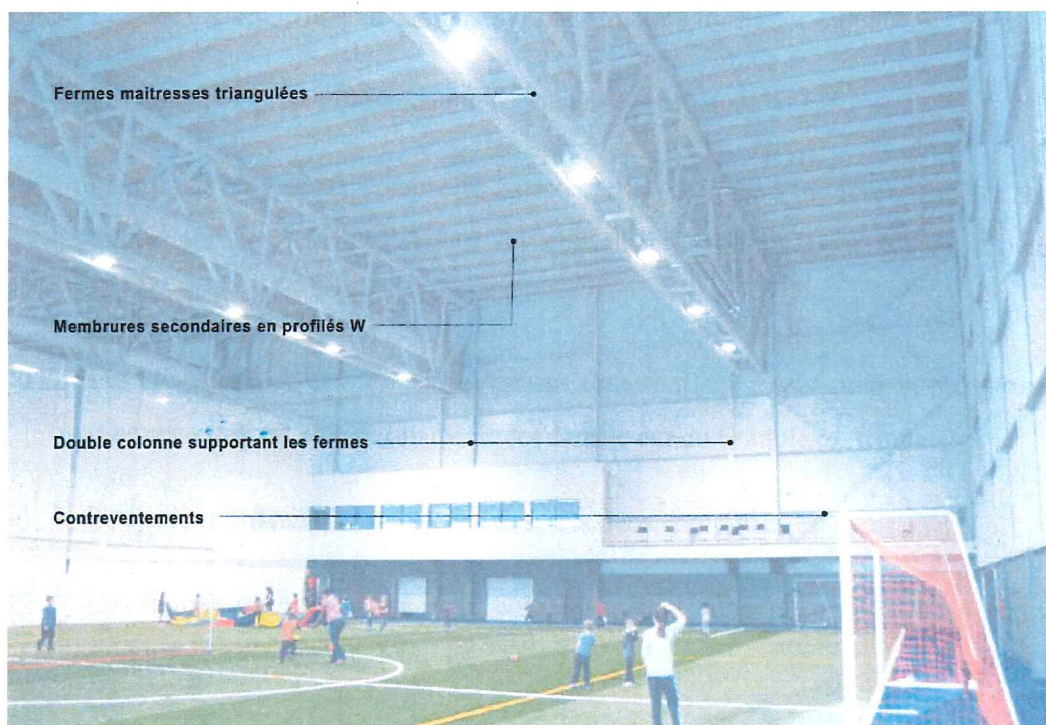
Fig. 33 – Vue d’ensemble du Complexe Victoriaville avec comparaison des éléments de structure similaires (Infographie ABCP)
