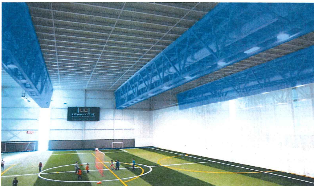
Fig. 20 – Fermes maitresses triangulées supportant des membrures en porte-à-faux (Infographie ABCP sur photographie représentative du Complexe Victoriaville)
